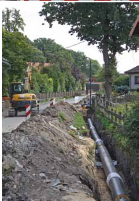
In Ahsnsbeck wurden 14 Kilometer Leitungsnetz verlegt, um die Häuser mit der Nahwärme versorgen zu können.
